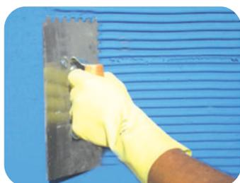
Com o lado liso da desempenadeira, aplique Pastimont e em seguida frise com o lado denteado (dentes de 6 a 8 mm).
